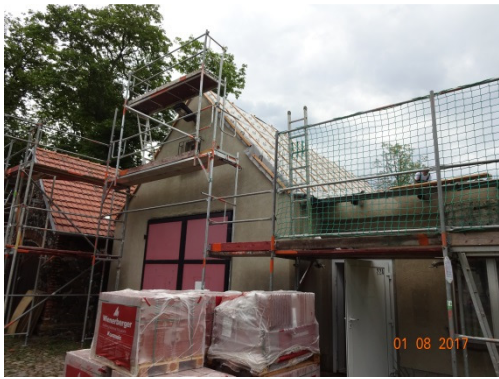
Traditionsfeuerwehr während der Bauarbeiten
