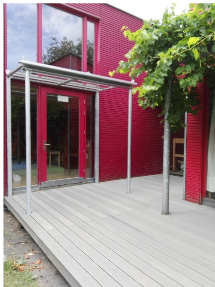
Terrasse nach Erneuerung Belag und Anbau Vordach
