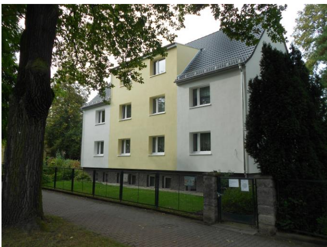
Fertigstellung kommunales Wohnhaus Friedrichshagener Straße 71
