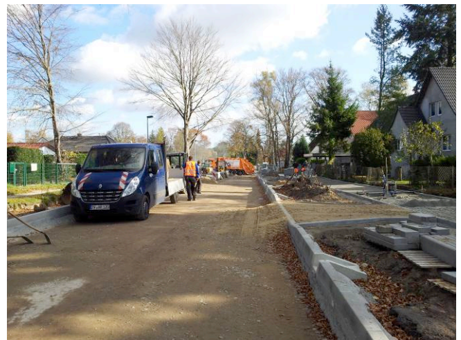
Kieferndamm, Vorbereitung der Asphaltarbeiten
