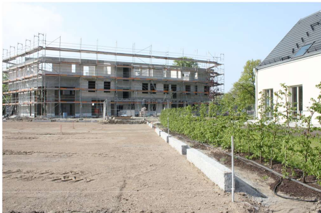
Der Parkplatz von Rathaus und KultOurKate in der Bauphase
