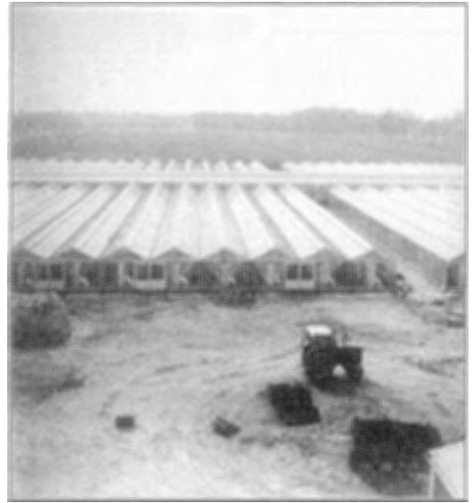
Bau des Gewächshauskomplexes der GPG Flora, Mai 1963
